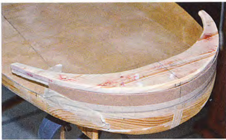
La mise en place du pavois et du plat-bord arrière.
